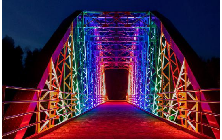
Puente de los Remedios, Villafranca de Cordoba 2022
